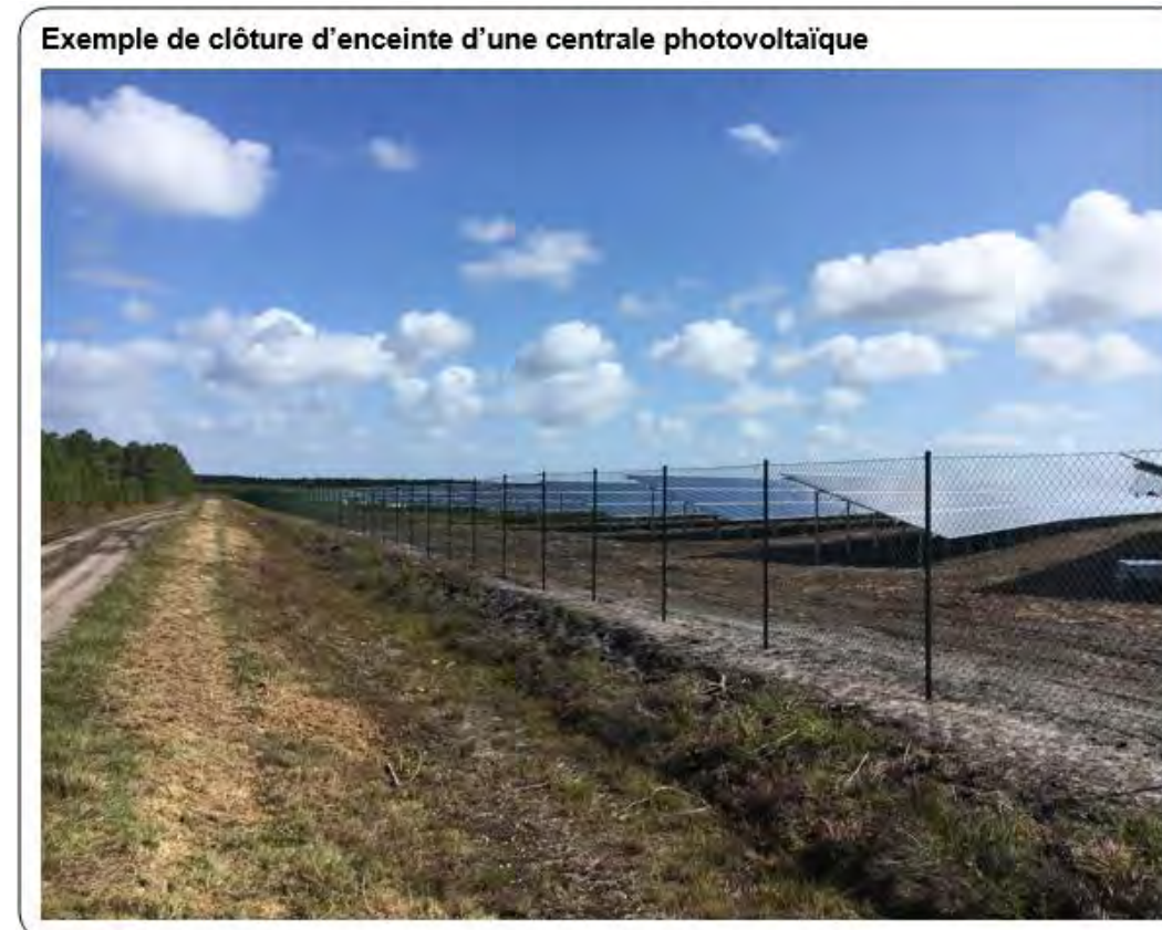
Figure 155 : Clôture de sécurité
