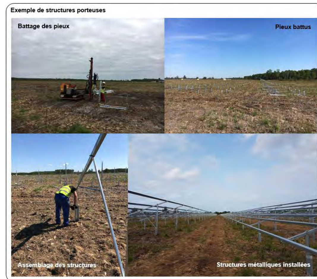
Figure 154 : Structures porteuses métalliques
