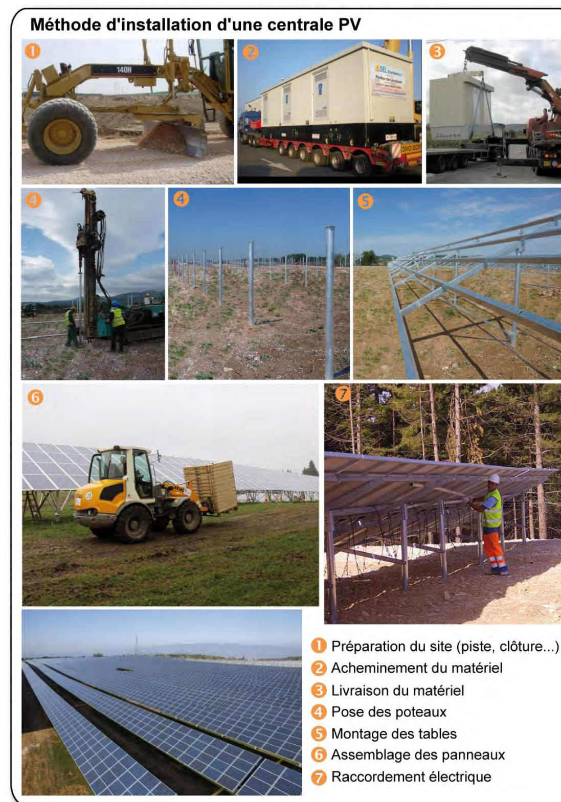
Figure 156 : Construction d'une centrale photovoltaïque
